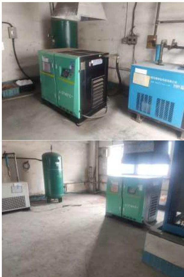
4 台 37kW 永磁電機及變頻功能的節能螺桿
